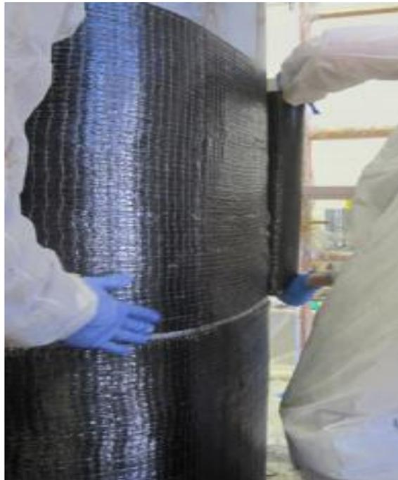
**Figure D.23** CFRP wrapping (Saini et al, 2013)
