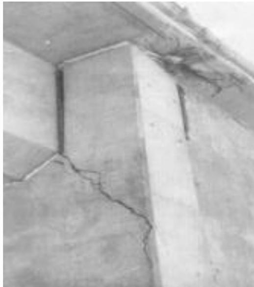
**Figure B.11** Damage State 5 (Saini et al, 2013)
